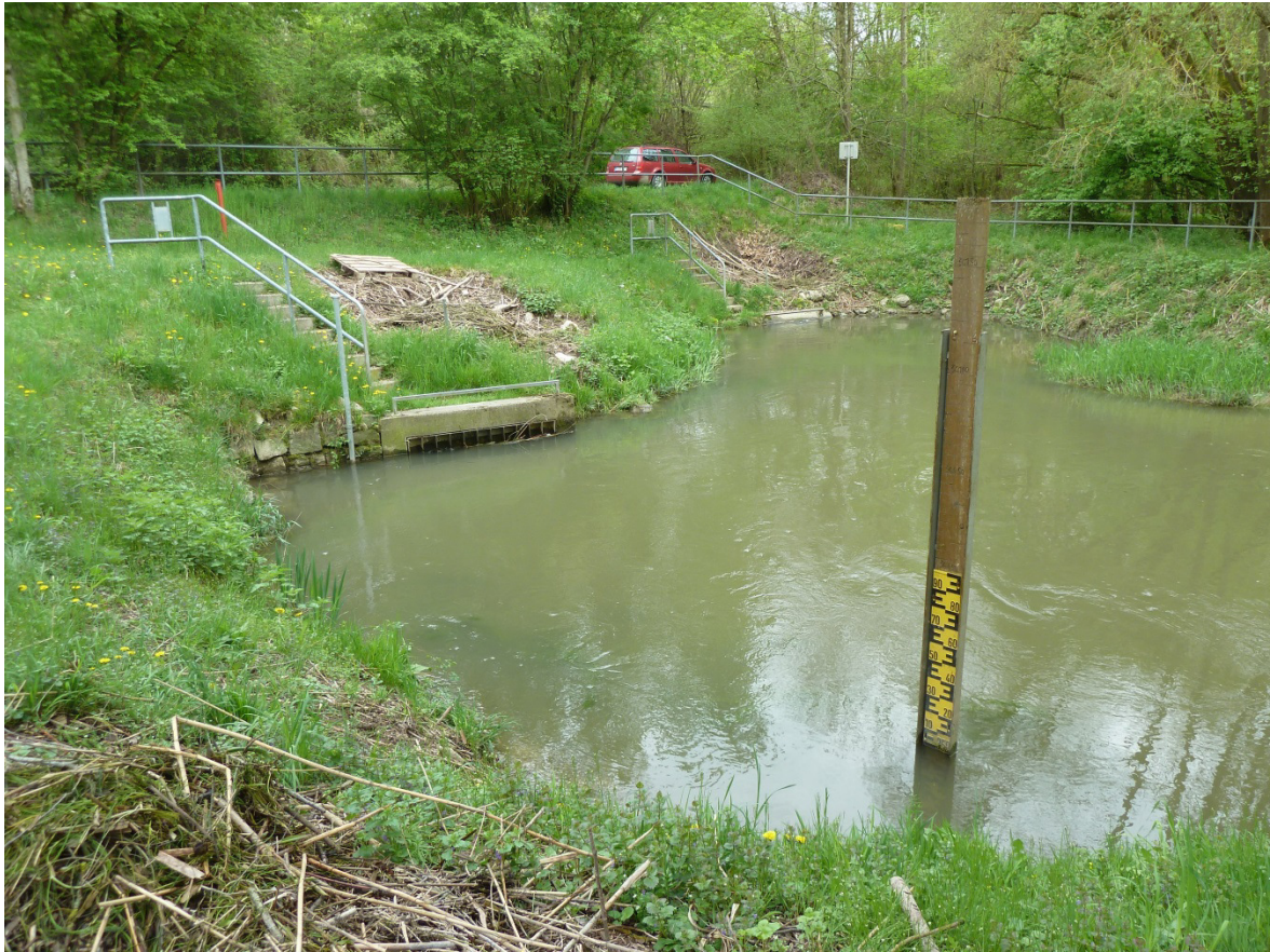
Abbildung 6: Durchlässe an der Großmehring Brücke (Oberwasser) – Foto BCE vom 19.04.2016
