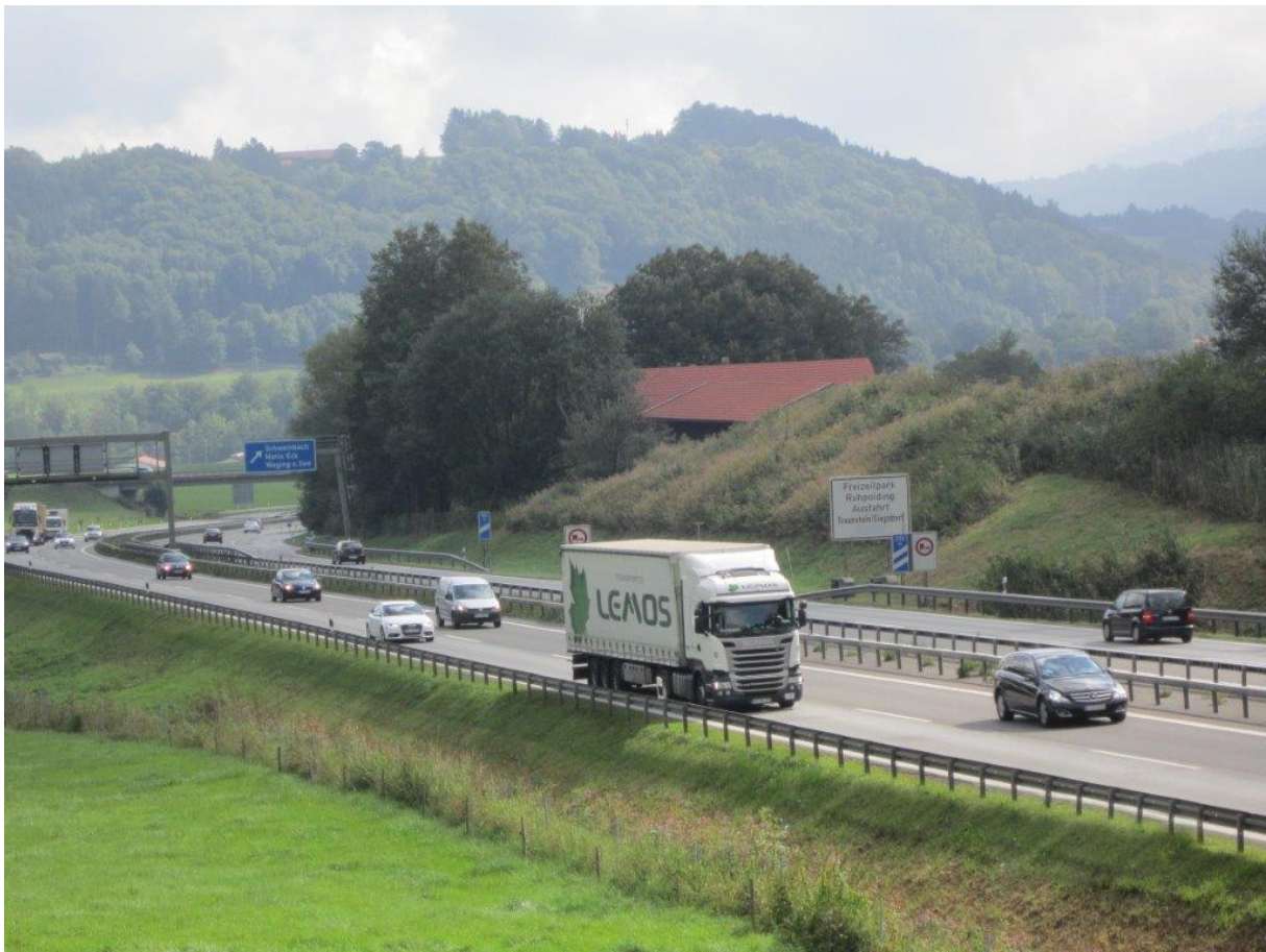
Abbildung 1: Anschlussstelle Schweinbach an der Bundesautobahn A 8 [1]
