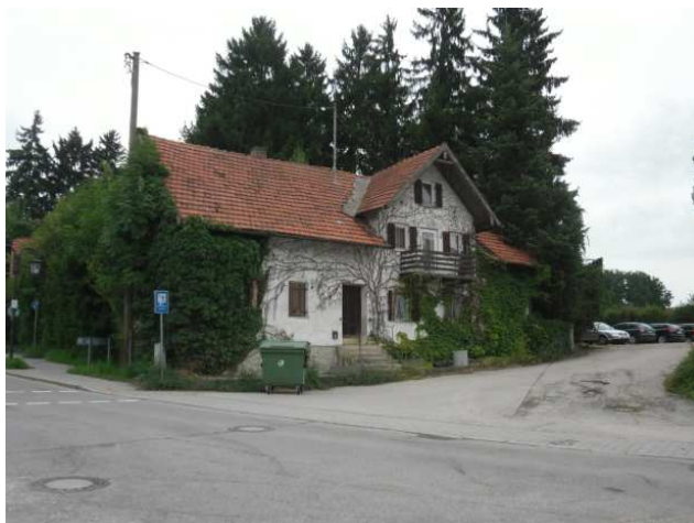
Bild 5: IO3 (nicht mehr existent)
