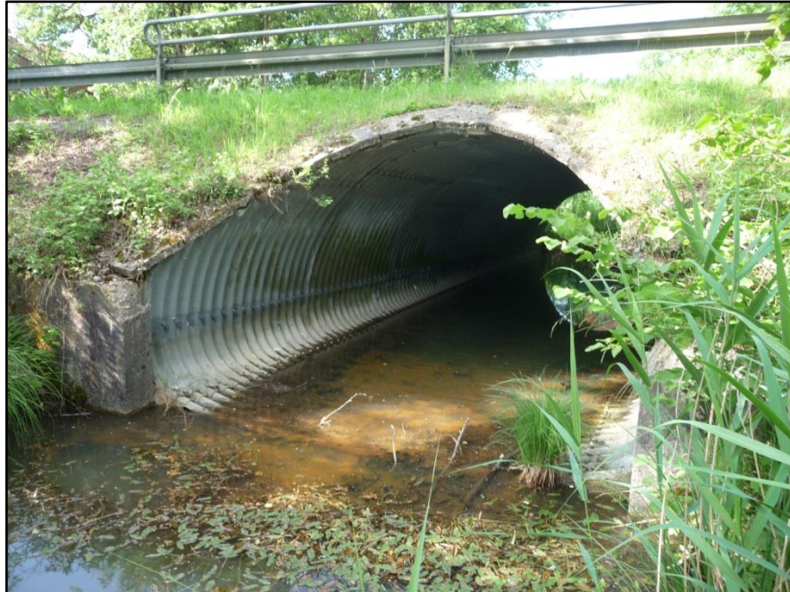
Abbildung 6: Wellstahldurchlass unter der St2062
