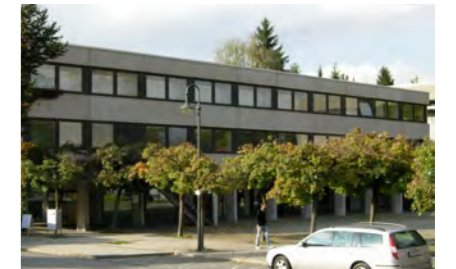
Zustand vor der Sanierung
