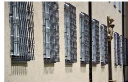
Insgesamt wurden von den 204 Fenstern des Rathauses 172 saniert
