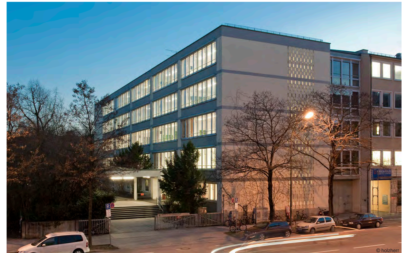
Filtermauerwerk an der Briener Straße
