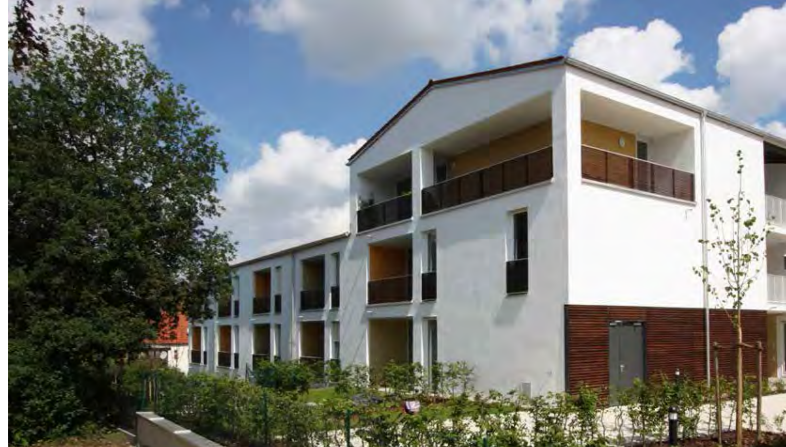
Die Höhenstaffelung des Gebäudes folgt dem vorhandenen Geländeverlauf und vermittelt zur Umgebungsbebauung.
