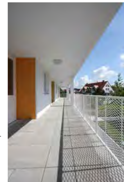
Alle Wohnungen sind stufenlos über einen einzigen Aufzugskern und angegliederte Laubengänge erreichbar.
