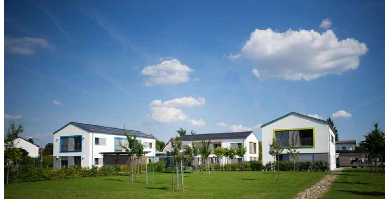
Die Gruppierung der einzelnen Gebäude schafft einen halb offenen und gleichzeitig privaten Terrassen- und Gartenbereich.
