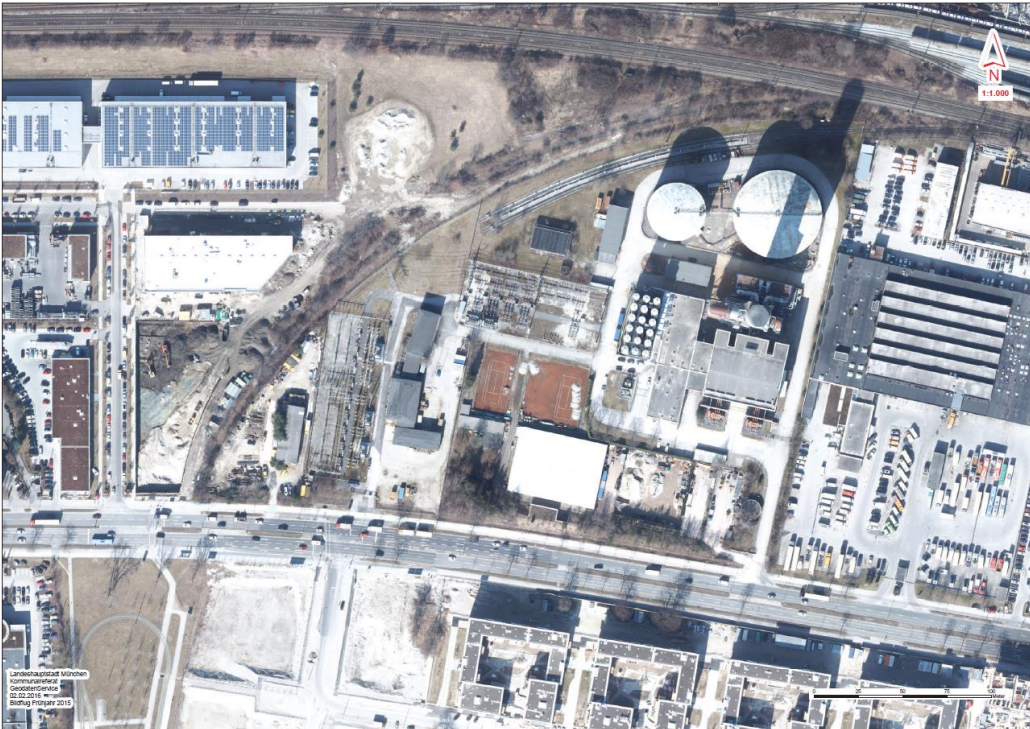
Abbildung 2.3: Luftaufnahme des Standorts im Frühjahr 2015 (von Süden) [Quelle: Kommunalreferat Geodatenservice der Landeshauptstadt München]
