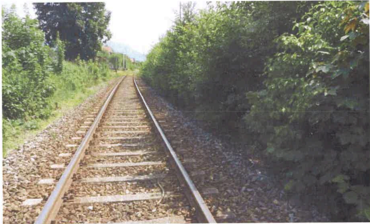
Abbildung 3: Gleise auf Höhe des geplanten Bahnübergangs.
