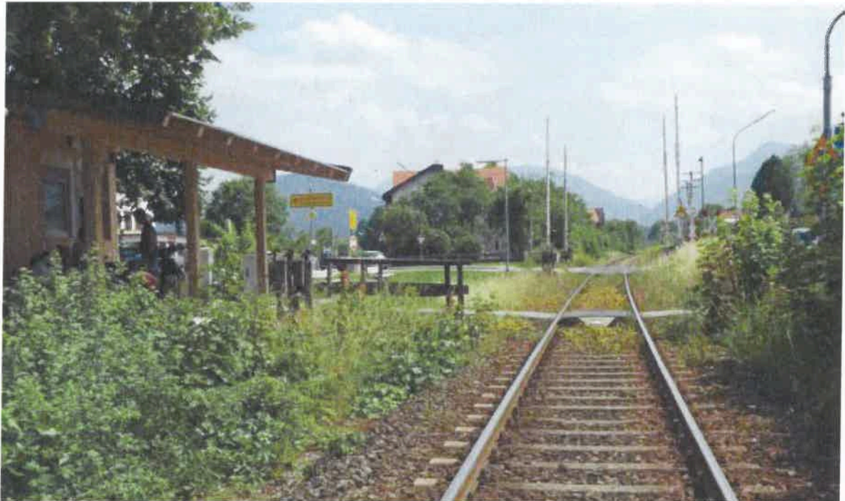
Abbildung 2: Bestehender Bahnübergang mit Wärterhäuschen, Fußgängerüberweg (vorne) und beschränktem Bahnübergang (hinten).
